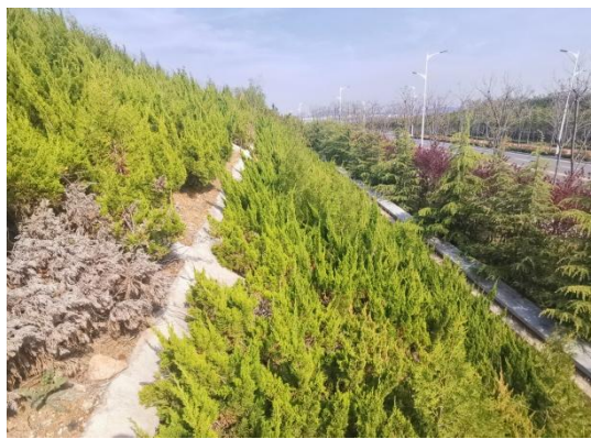
边坡框格栽植灌木护坡
