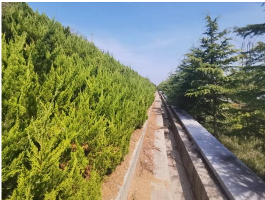
开挖边坡坡脚排水沟
