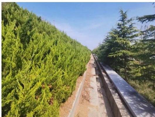
边坡框格栽植灌木护坡
