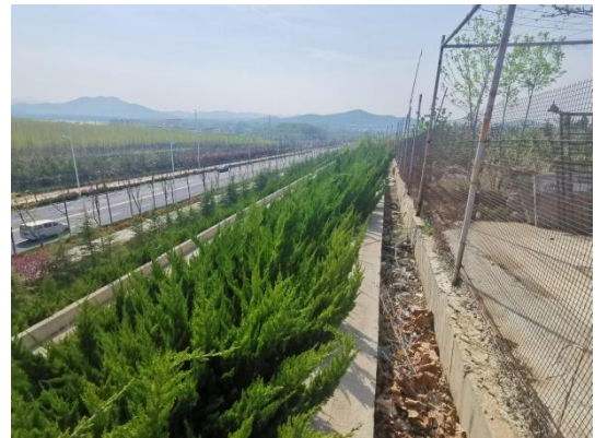
开挖边坡边坡顶截水沟
