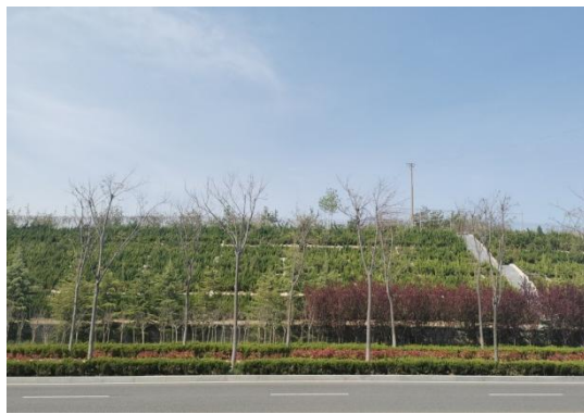
边坡框格栽植灌木护坡
