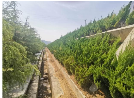
边坡框格护坡
